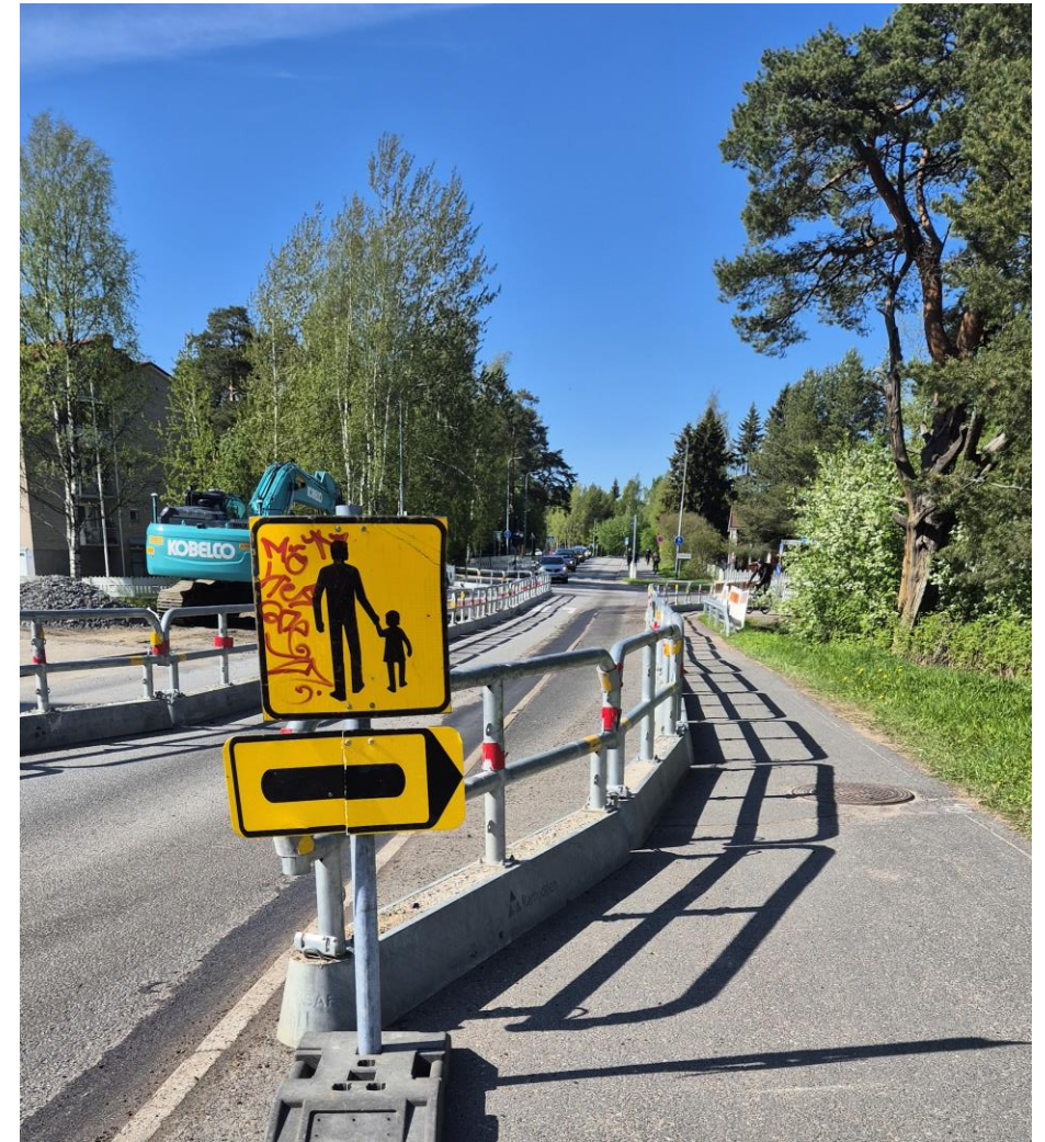
Kuva 1. Koskelantien työmaanaikaisia liikennejärjestelyitä.
