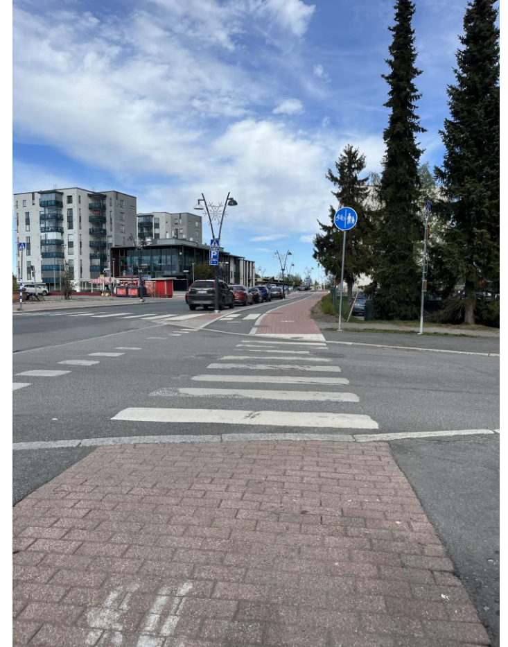
Kuva 19. Suupantien erotettu jalkakäytävä ja pyörätie.
