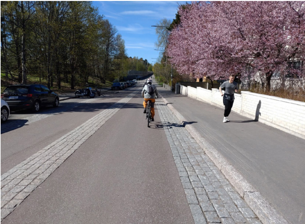
Kulosaaren puistotie Helsingissä on Suomen pisin (1,3 km) ja vilkasliikenteisin pyöräkatu. Pyöräliikenteen määrä on yli puoli miljoonaa matkaa vuodessa.
