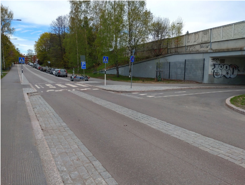
Kulosaaren puistotiellä pyöräkatuun sivusuunnasta liittyvä 2-suuntainen pyörätie on toteutettu liitoskohdastaan selkeästi ja turvallisesti.
