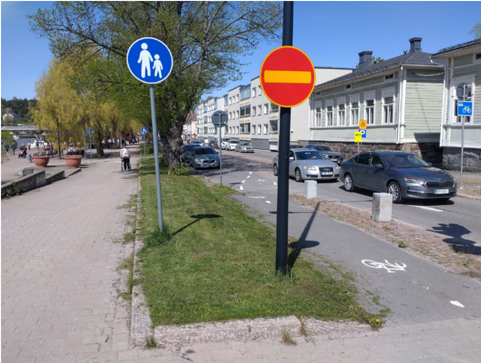
Porvoon Jokikadun uudistuksen myötä rantabulevardi on osoitettu vain jalankulkuun ja oleskeluun.
