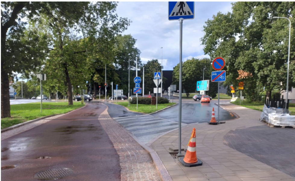
Kauppias Hammarin kadun pyöräkatu Turussa jatkuu 2-suuntaisena pyörätienä ja jalkakäytävänä.
