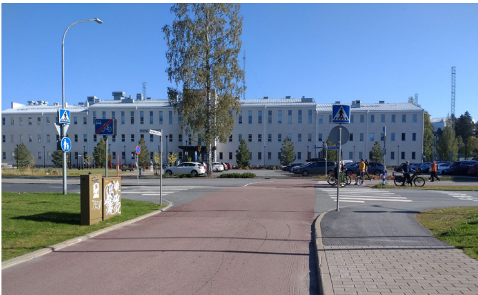
Honkapolku on Joensuun pyöräkatujen suunnitteluperiaatteiden mukaisesti etuajo-oikeutettu risteävään Peltolankatuun nähden, vaikka Peltolankatu on kohtuullisen vilkkaasti liikennöity.
