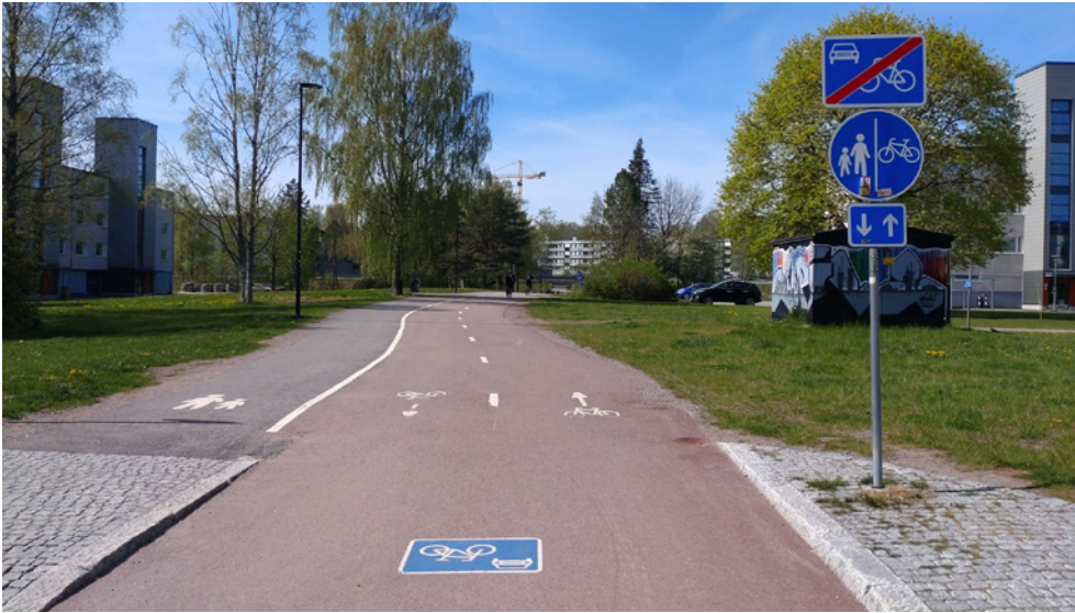
Maistraatinkadun pyöräkatu Porvoossa muuttuu pyörätieksi. Liitoskohtien laatu ja selkeys on tärkeää niin sujuvuuden kuin turvallisuudenkin kannalta.
