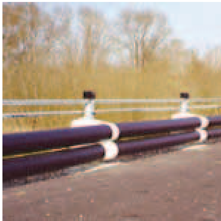
Kuva 2.1. Moottoripyöräilijäystävällinen sivukaideratkaisu. Kuva: Sodirel.
