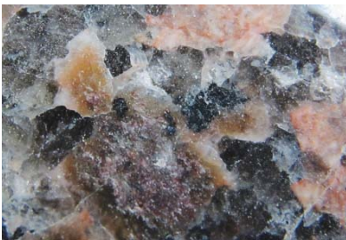
Nastan jälkiä kivilevyn pinnalla
