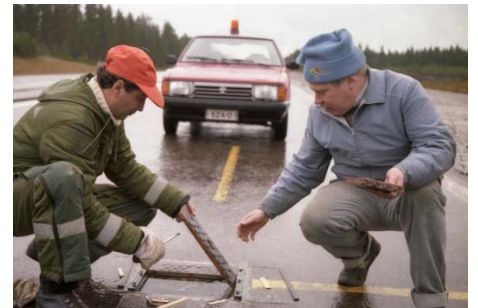
Kuva 1. Koekappaleiden asennus alustaan.
