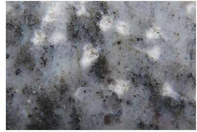
Nastan jälkiä kivilevyn pinnalla
