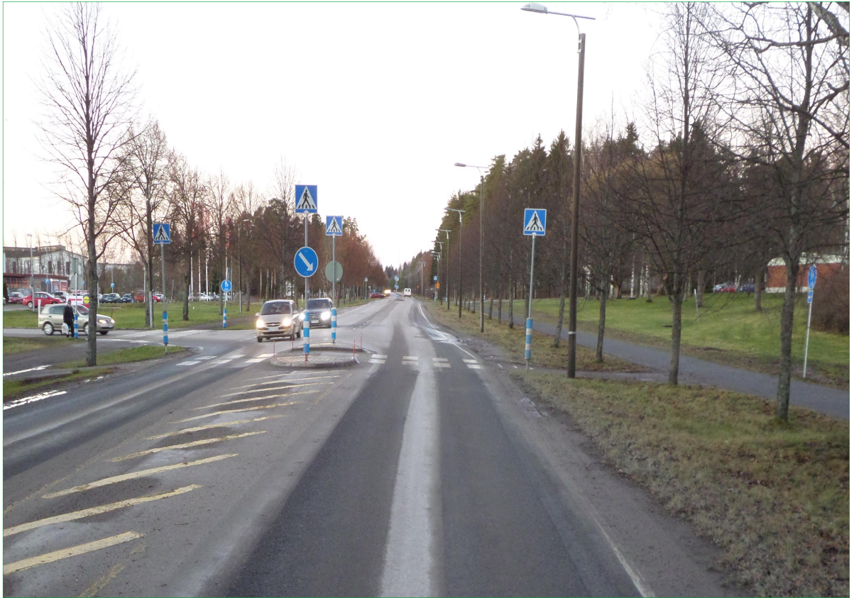
Kuva 50. Mt290, Harvialantie, Lidlin liittymä – kuva toimenpiteiden toteuttamisen jälkeen (toimenpiteet nro 23).
