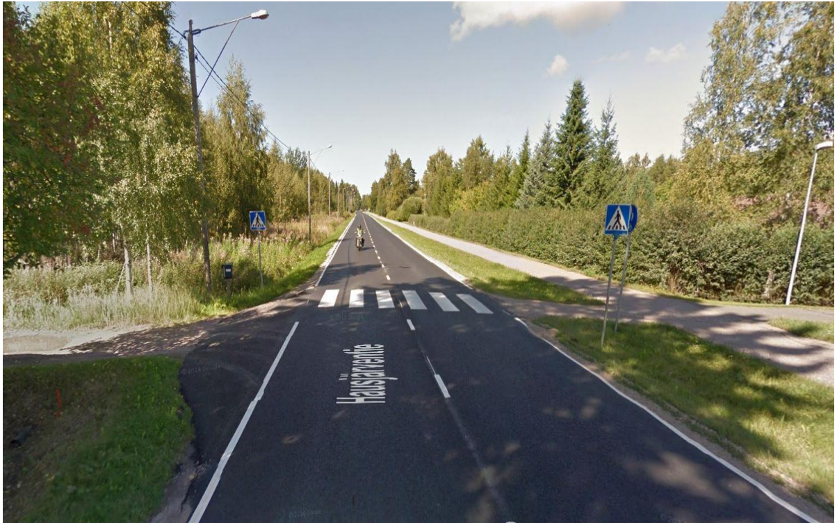
Kuva 64. Mt290, Hausjärventie, Hausjärventie 220 –kohta – kuva ennen toimenpiteiden toteuttamista (toimenpiteet nro 29).
