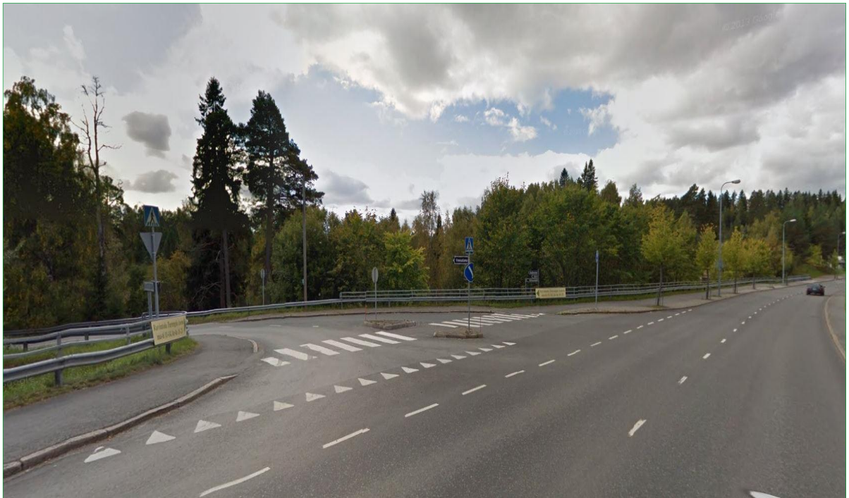
Kuva 19. Mt 292, Turengintie, Asematien liittymä – kuva ennen toimenpiteiden toteuttamista (toimenpiteet nro 8).
