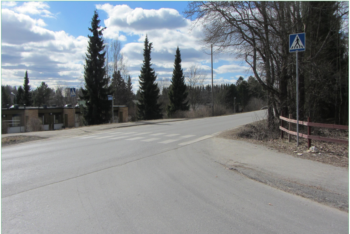
Kuva 41 Mt292, Lammintie, Kekanahontien liittymä – kuva ennen toimenpiteiden toteuttamista (toimenpiteet nro 20).
