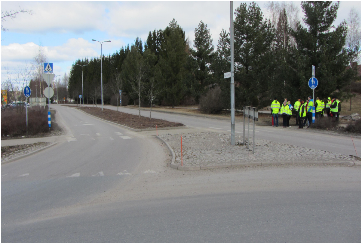
Kuva 32. Mt292, Turengintie/Lammintie – Mt290, Hausjärventie/Harvialantie, kiertoliittymän pohjoinen suojatie – kuva ennen toimenpiteiden toteuttamista (toimenpiteet nro 15).
