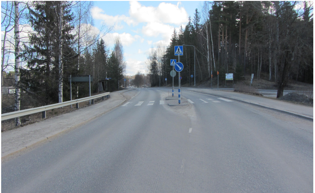
Kuva 71. Mt 292, Turengintie - Lukiotien liittymä – kuva ennen toimenpiteiden toteuttamista (toimenpiteet nro 10).
