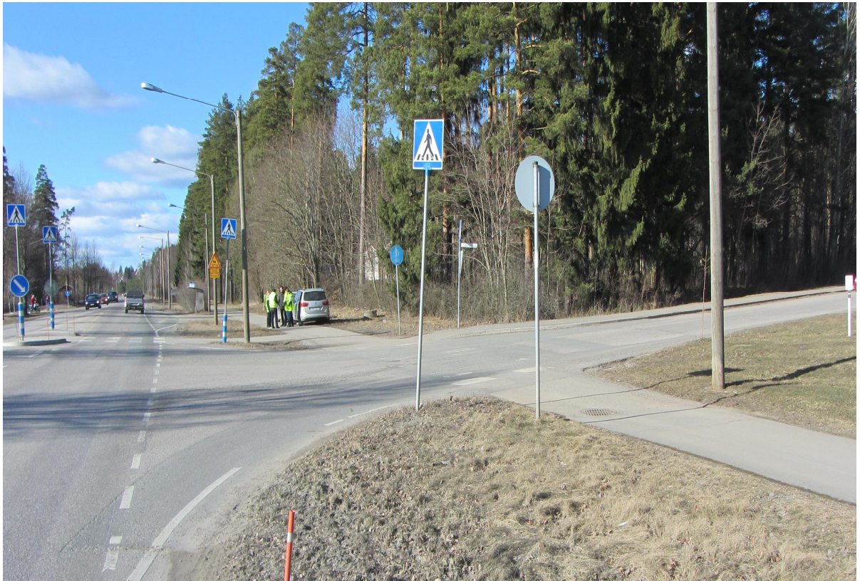
Kuva 46. Mt290, Harvialantie, Tapailankujan liittymä – kuva ennen toimenpiteiden toteuttamista (toimenpiteet nro 22).
