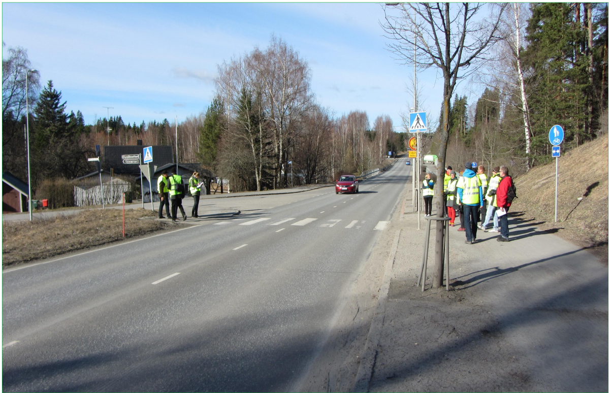
Kuva 14. Mt 292, Turengintie - Pyhämäentien liittymä – kuva ennen toimenpiteiden toteuttamista (toimenpiteet nro 5).
