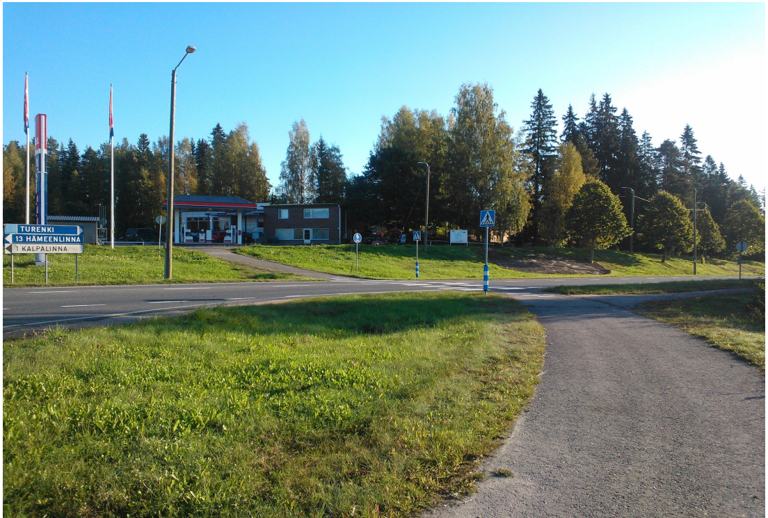
Kuva 8. Mt292, Turengintie, Hakoistentien liittymä – kuva toimenpiteiden toteuttamisen jälkeen (toimenpiteet nro 2).
