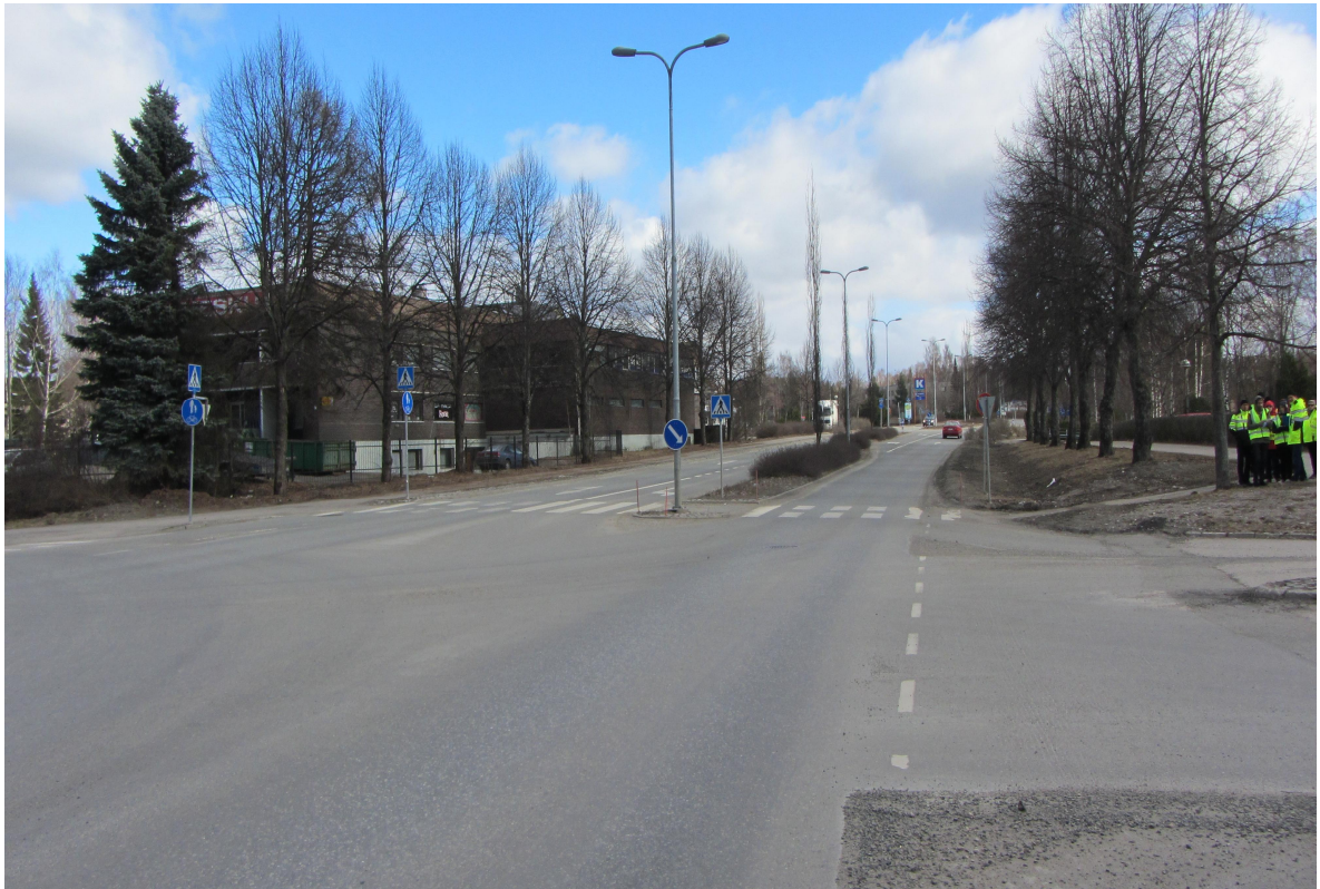
Kuva 29. Mt292, Janakkalantie – Juttulantie /Tohvelantie, itäpuolen suojatie – kuva ennen toimenpiteiden toteuttamista (toimenpiteet nro 13).
