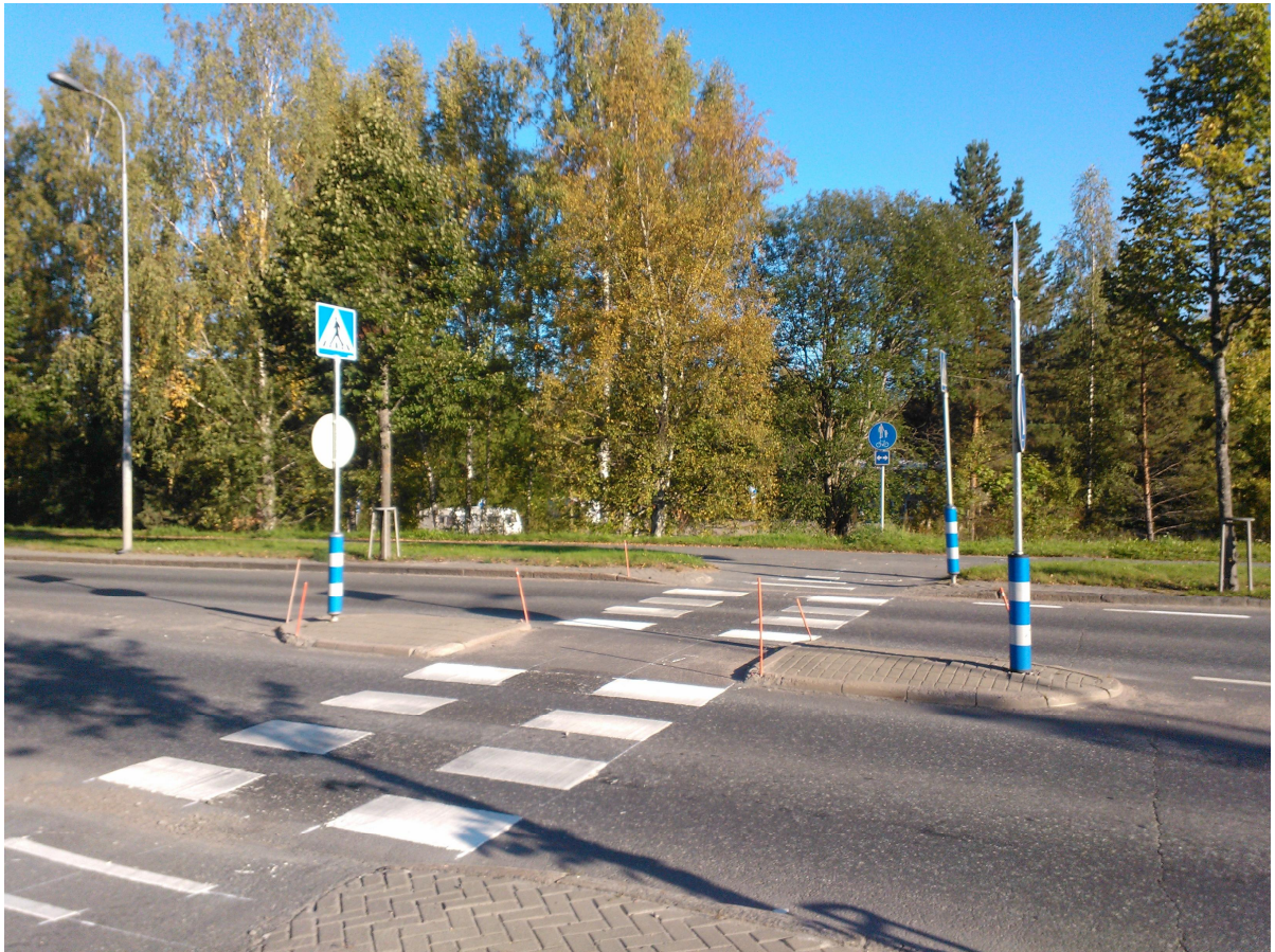
Kuva 17. Mt292, Turengintie – Liinalammentie – kuva toimenpiteiden toteuttamisen jälkeen (toimenpiteet nro 7).
