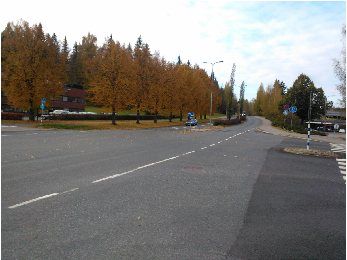
Kuva 28. Mt292, Janakkalantie – Juttulantie/Tohvelantie, länsipuolen suojatie – kuva toimenpiteiden toteuttamisen jälkeen (toimenpiteet nro 12).
