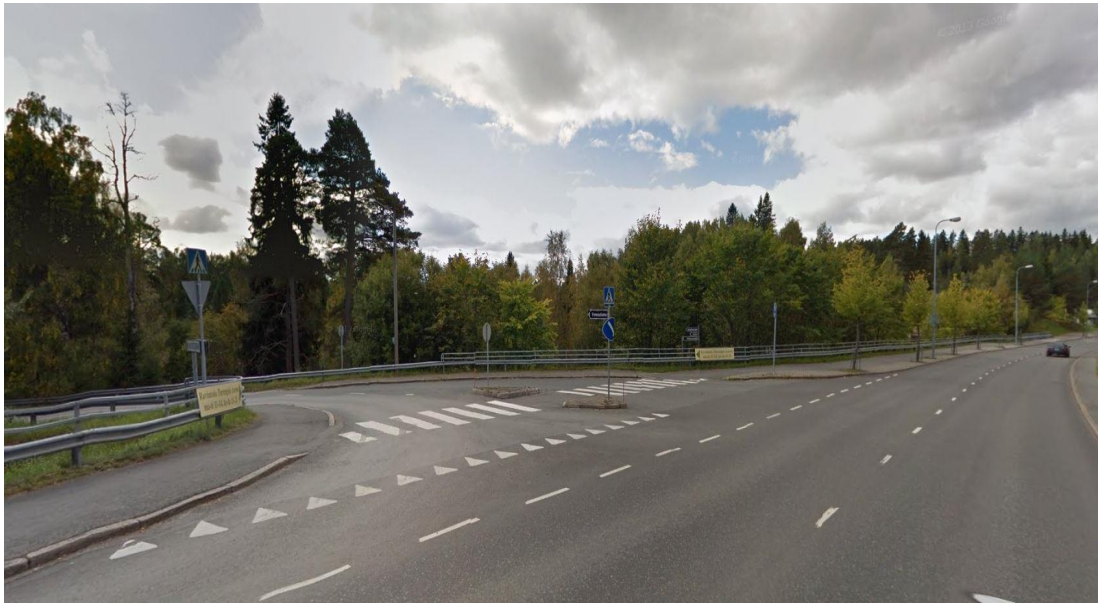
Kuva 69. Mt 292, Turengintie, Asematien liittymä – kuva ennen toimenpiteiden toteuttamista (toimenpiteet nro 8).
