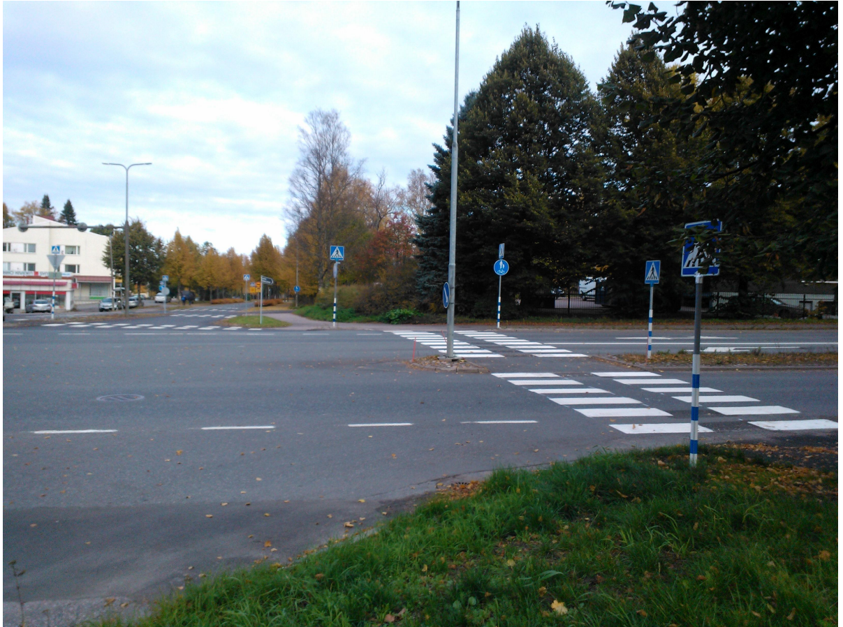
Kuva 30. Mt292, Janakkalantie – Juttilantie/Tohvelantie, itäpuolen suojatie – kuva toimenpiteiden toteuttamisen jälkeen (toimenpiteet nro 13).
