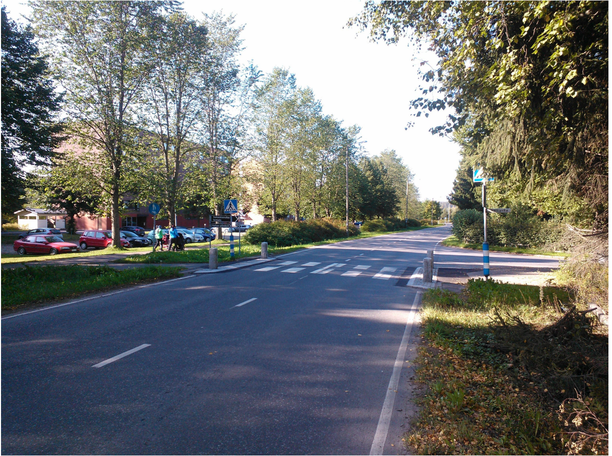
Kuva 39. Mt292, Lammintie, Haltiantien liittymä – kuva toimenpiteiden toteuttamisen jälkeen (toimenpiteet nro 18).
