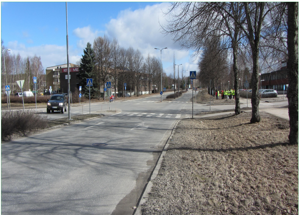
Kuva 27. Mt292, Janakkalantie – Juttilantie/Tohvelantie, länsipuolen suojatie – kuva ennen toimenpiteiden toteuttamista (toimenpiteet nro 12).
