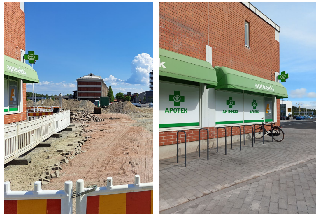
Ennen ja jälkeen: Torinkulman työmaa rakentamisen aikana ja valmiina. Kuvat: Kaarinan kaupunki.
