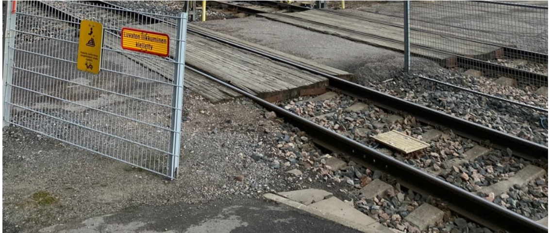
Kuva 11. Kieltokyltit sekä aidan ja laiturin väliin jäävä aukko.
