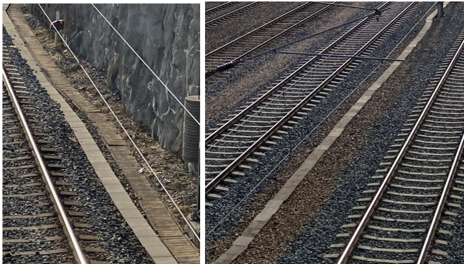
Kuva 10. Betonikansia, joita pitkin luvattomia liikkujia on raportoitu kulke- neen.
