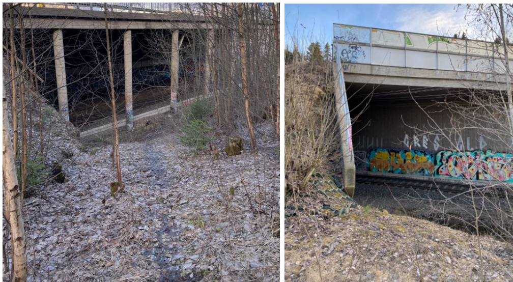
Kuva 14. Ylikulkusillan alle johtavat kulkureitit.
