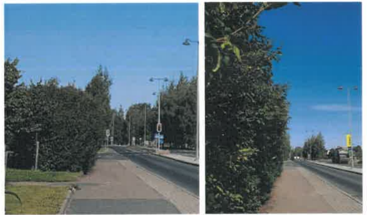
Pensasaita kaventaa pyöräliikenteen ja jalankulun väylällä käytettävissä olevaa tilaa sekä heikentää näkemiä
