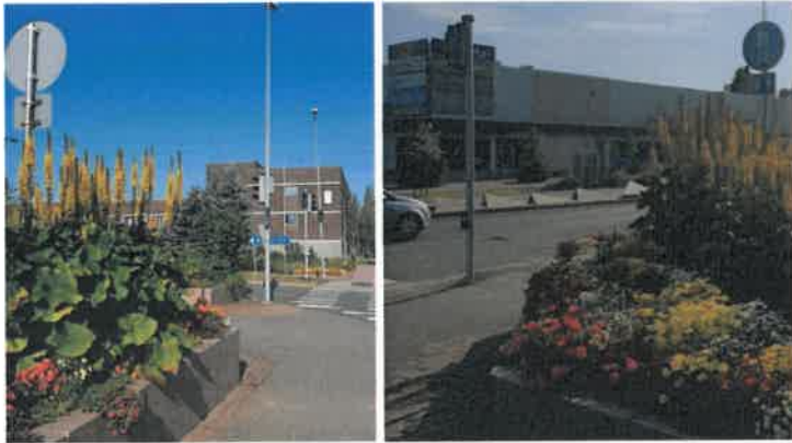
Liittymässä on näkemäalueella silmäpistekorkeuden (1,5 m) ylittävää kasvillisuutta.
